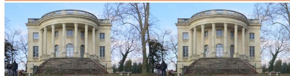
Figure 5. Le château Peychotte ou Maison Carrée d'Arzac à Mérignac en Gironde. Photo : René Le Menn
