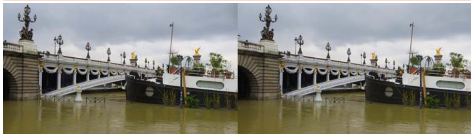
Crue de la Seine, Paris, février 2021 - Pont Alexandre III - Photo : Pierre Meindre
