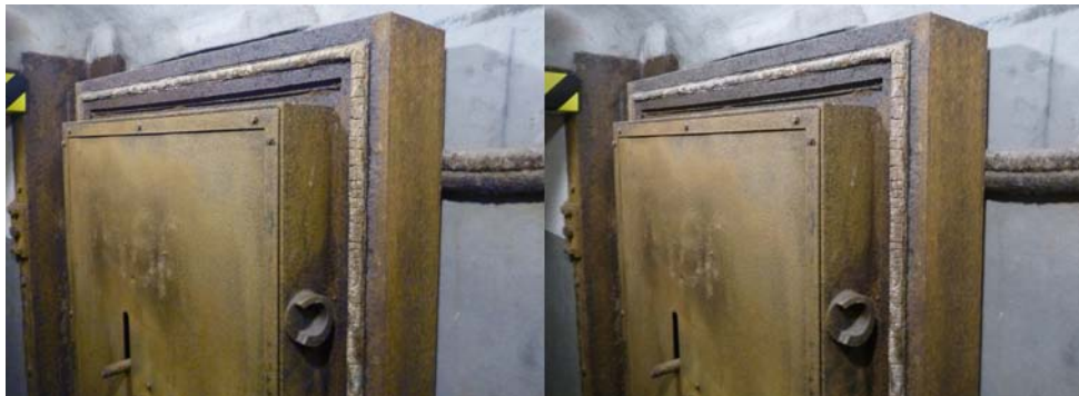
Bienvenue dans le poste de commandement souterrain ! - Photo : Pierre Meindre
