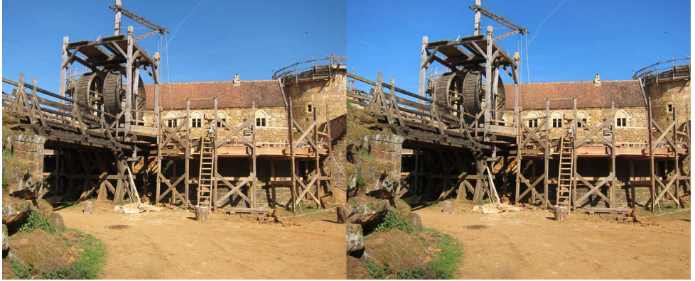
Chantier de l'entrée du château
