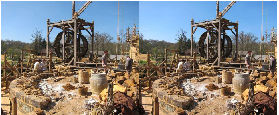
Chantier d'une des tours de l'entrée
