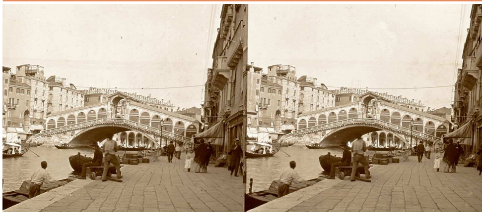
Venise, le pont du Rialto sans vaporetto - Photo : Maurice Filloux
