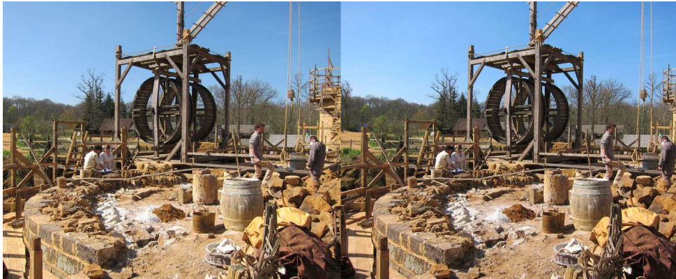
Chantier d'une des tours de l'entrée
