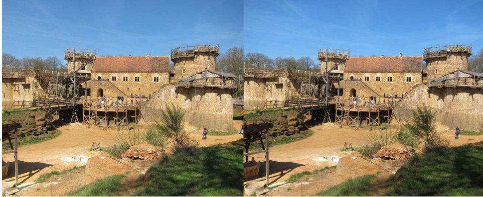
Vue générale du château
