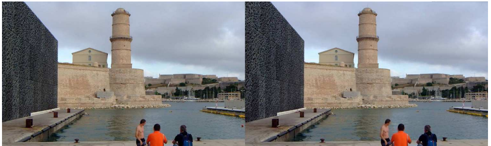
Illustration 1. L'ancien phare du fort Saint-Jean et l'extension moderne du MuCEM, en arrière-plan le fort Saint-Nicolas, Marseille - Photo : Jean-Yves Gresser
