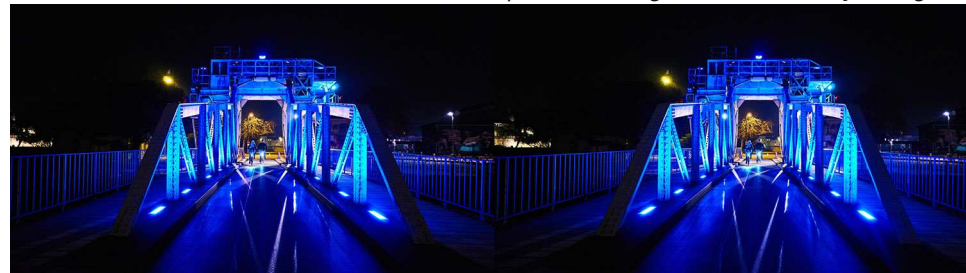
Pont levant à La Rochelle, Charente-Maritime - Photo : Dominique Bretheau
