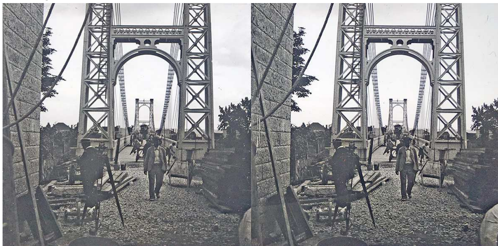
1899 - Construction du pont de Port Sainte-Marie, Lot & Garonne - Collection Patrick Durand
