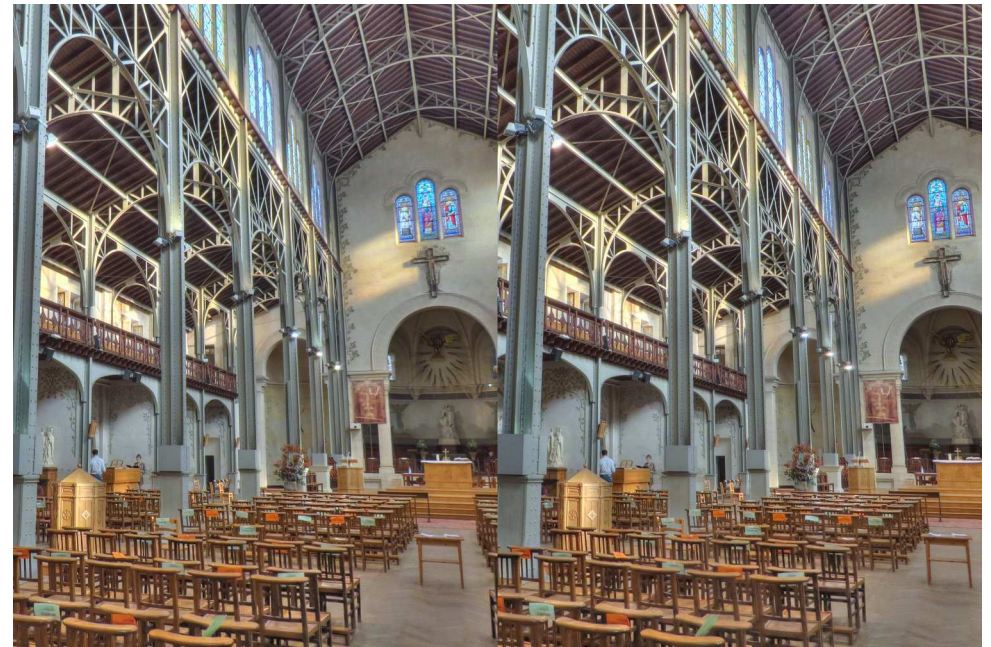
Église Notre-Dame-du-Travail, Paris 14 e (1897-1902) - Photo : Pierre Meindre Grande innovation pour l'époque, sa structure métallique et ses poutrelles apparentes.
