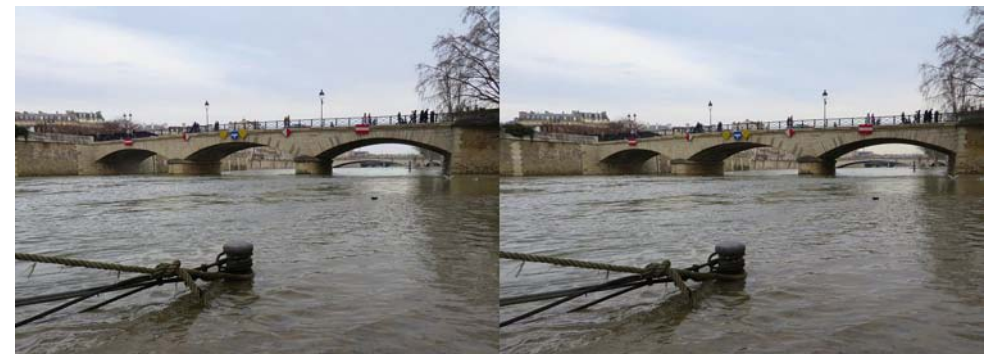
Crue de la Seine, Paris, février 2021, pont de l'Archevêché - Photo : Pierre Meindre
