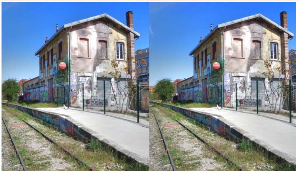
Gare du pont de Flandre sur la Petite Ceinture - Photo : Pierre Meindre
