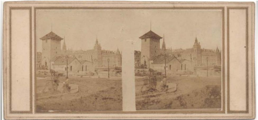
*Le pont et la pompe Notre-Dame vus du quai de Gesvres, photographe inconnu, fin 1852. Le mètre et demi entre l'avant-toit du bâtiment et le haut du parapet montre à quel point le pont a dû être abaissé pour s'aligner sur la nouvelle rue de Rivoli.*
