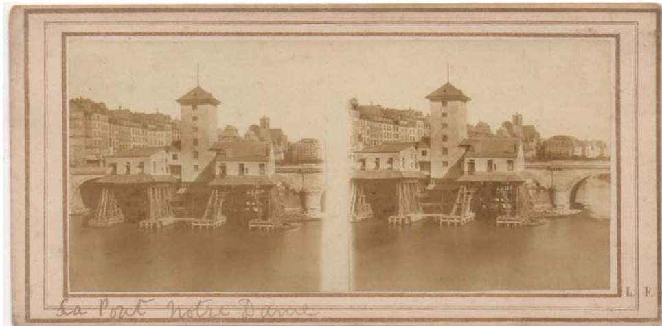
Le pont Notre-Dame, par L. F. (Léauté Frères), entre janvier 1853 et avril 1855. La pile semi-circulaire montre que c'est le nouveau pont Notre-Dame. Juste-au-dessus cette pile, au loin, à droite de Saint-Gervais, un îlot de bâtiments reste en place. Sa démolition a commencé en avril 1855.
