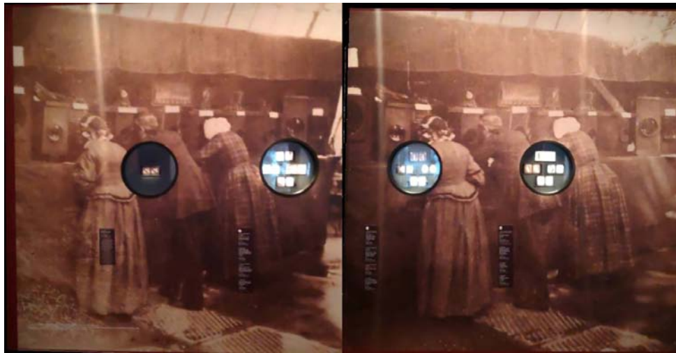
Installation des "quatre hublots" - Photo : Jean-Yves Gresser
