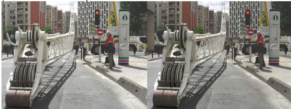
La flèche du camion-grue est en cours de montage à Montreuil - Photo : Roger Huet
