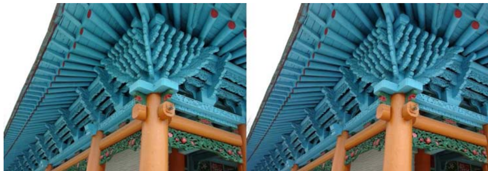
Mosquée de Karakol (construite en 1910 par des bouddhistes chinois), Kirghizistan Photo : Daniel Courvoisier
