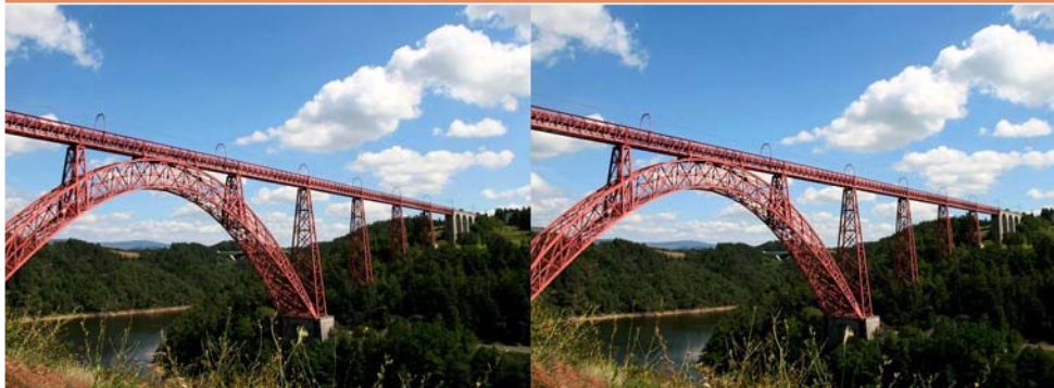
Le viaduc de Garabit. Enjambant La Truyère, affluent du Lot, dans le département du Cantal ce viaduc ferroviaire date de 1884. Entièrement métallique, il a été construit par la société Gustave Eiffel. Il fait 565 mètres de long, l'arche principale 165 m, 122 m au-dessus du niveau d'étiage de la rivière. La vitesse des trains est aujourd'hui limitée à 10 km/h sur cette vénérable construction - Photo : Charles Clerc
