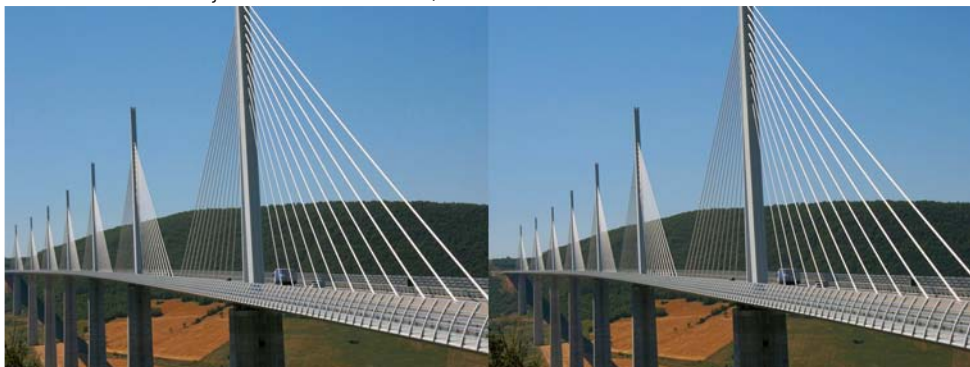
Le viaduc de Millau. Inauguré en 2004, ce viaduc autoroutier long de 2460 mètres franchit la vallée du Tarn, dans le département de l'Aveyron. Il est le plus haut pont à haubans du monde avec 343 mètres, le tablier culminant à 270 m au dessus de la rivière. - Photo : Charles Clerc
