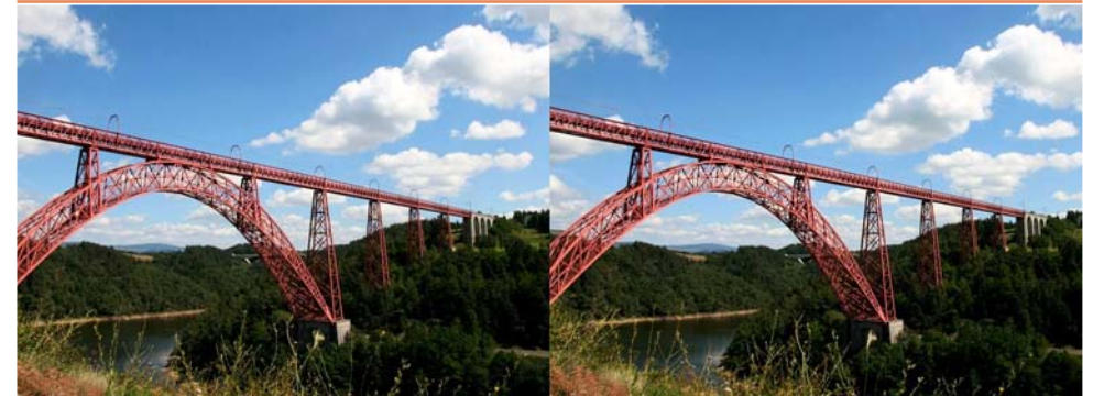
Le viaduc de Garabit. Enjambant La Truyère, affluent du Lot, dans le département du Cantal ce viaduc ferroviaire date de 1884. Entièrement métallique, il a été construit par la société Gustave Eiffel. Il fait 565 mètres de long, l'arche principale 165 m, 122 m au-dessus du niveau d'étiage de la rivière. La vitesse des trains est aujourd'hui limitée à 10 km/h sur cette vénérable construction - Photo : Charles Clerc
