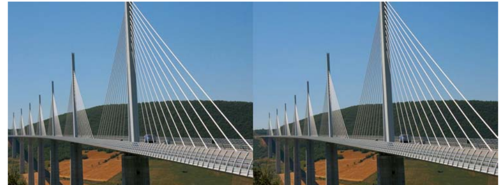
Le viaduc de Millau. Inauguré en 2004, ce viaduc autoroutier long de 2460 mètres franchit la vallée du Tarn, dans le département de l'Aveyron. Il est le plus haut pont à haubans du monde avec 343 mètres, le tablier culminant à 270 m au dessus de la rivière. - Photo : Charles Clerc
