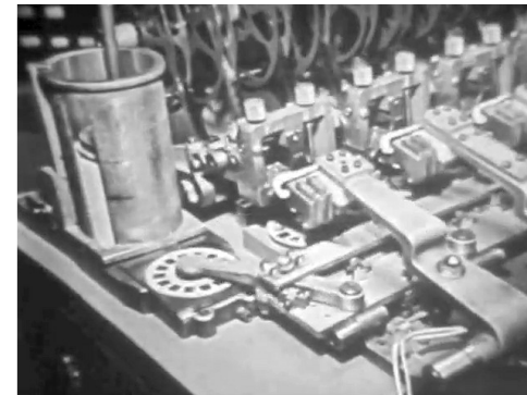
La fascinante machine fabriquant les disques View-Master dans les années 1950.
