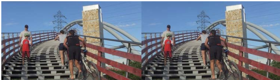
La nouvelle passerelle du port de Nanterre - Photo : Pierre Parreaux
