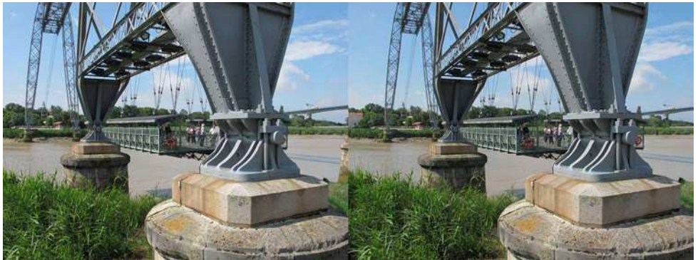
La nacelle mobile du pont transbordeur de Rochefort (Charente-Maritime) termine la traversée du fleuve - Photo : Roger Huet
