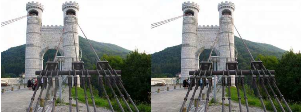
Le pont Charles-Albert (ou pont de la Caille) à Cruseilles, Haute-Savoie - Photo : Roger Huet
