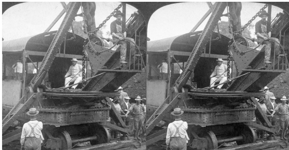
Le président des États-Unis Theodore Roosevelt aux commandes d'une excavatrice à vapeur lors d'une visite sur le chantier du creusement du canal de Panama en 1906. Carte stéréo ancienne Underwood & Underwood de la collection de la Library of Congress. http://www.loc.gov/pictures/collection/stereo/item/2011647853
