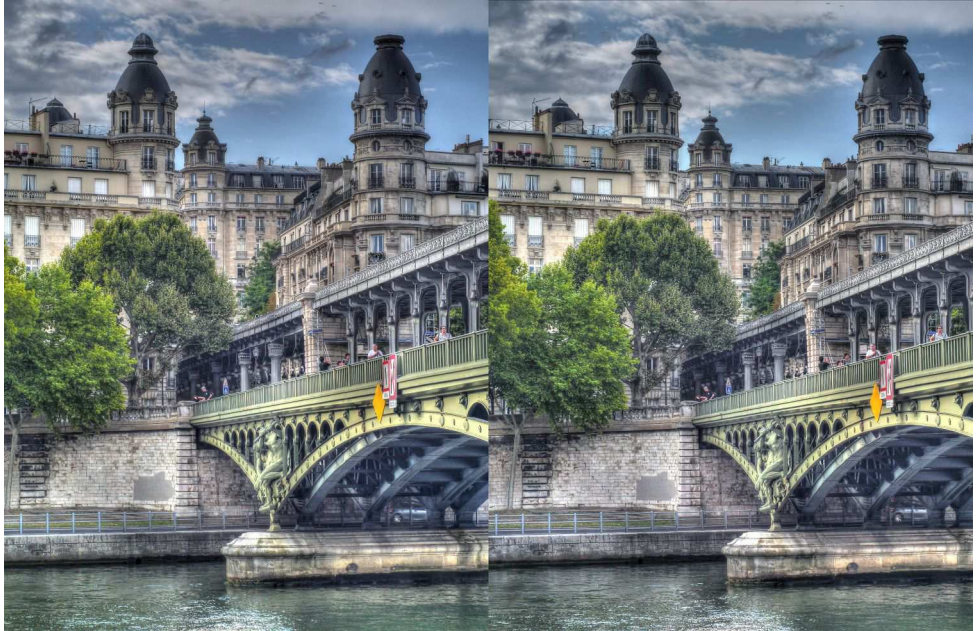
Le pont de Bir-Hakeim et le 16 e arrondissement de Paris - Photo : Pierre Meindre
