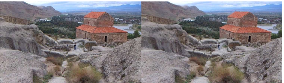
2.2. Église au plan basilical datant des 9 e / 10 e siècles, construite sur un éperon dominant la vallée.
