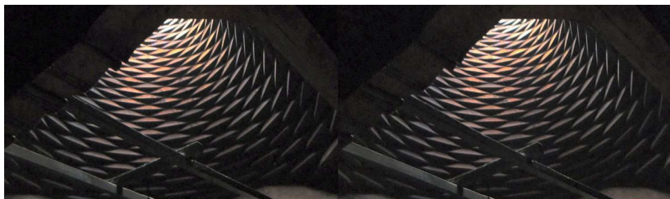
4.3. Voûte en « pomme de pin », qui servait, dans ce type de construction montagnarde, de cheminée et de puits de lumière.
