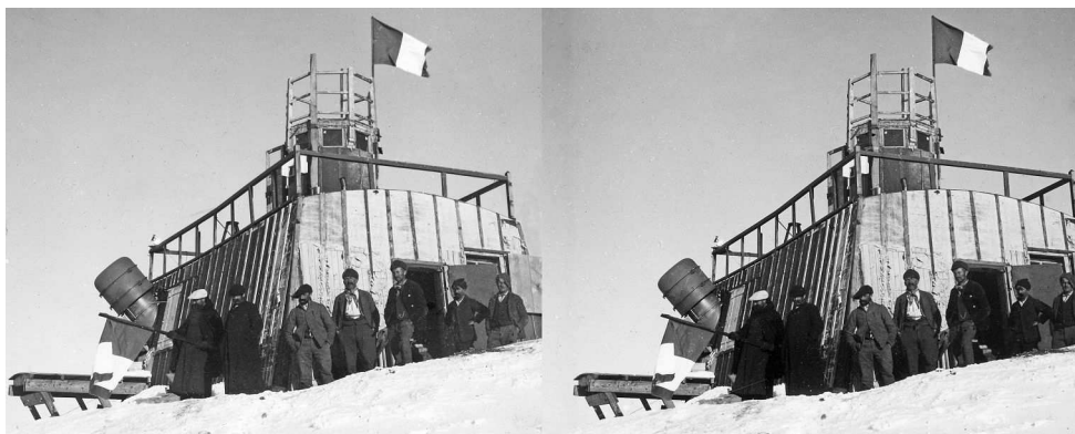
Observatoire du sommet du Mont-Blanc, 1906 - Collection et restauration Roger Huet
